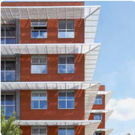
Kantoor KVLV, Sunclips® EVO SE.096, Wijkmaal (BE)
