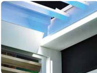
Geïntegreerde LED-verlichting aan de binnenzijde van het kader. Voorzien van opwaartse en/of neerwaartse verlichting. Hiermee voorzie je indirecte of directe sfeerverlichting - Camargue® , Algarve® .
